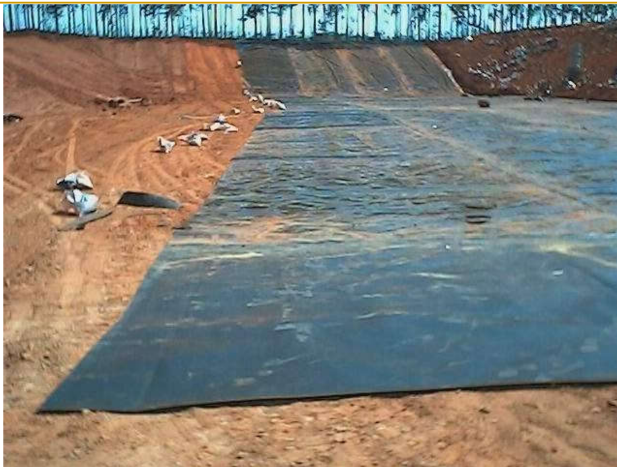
Detalhe da colocação da geomembrana
