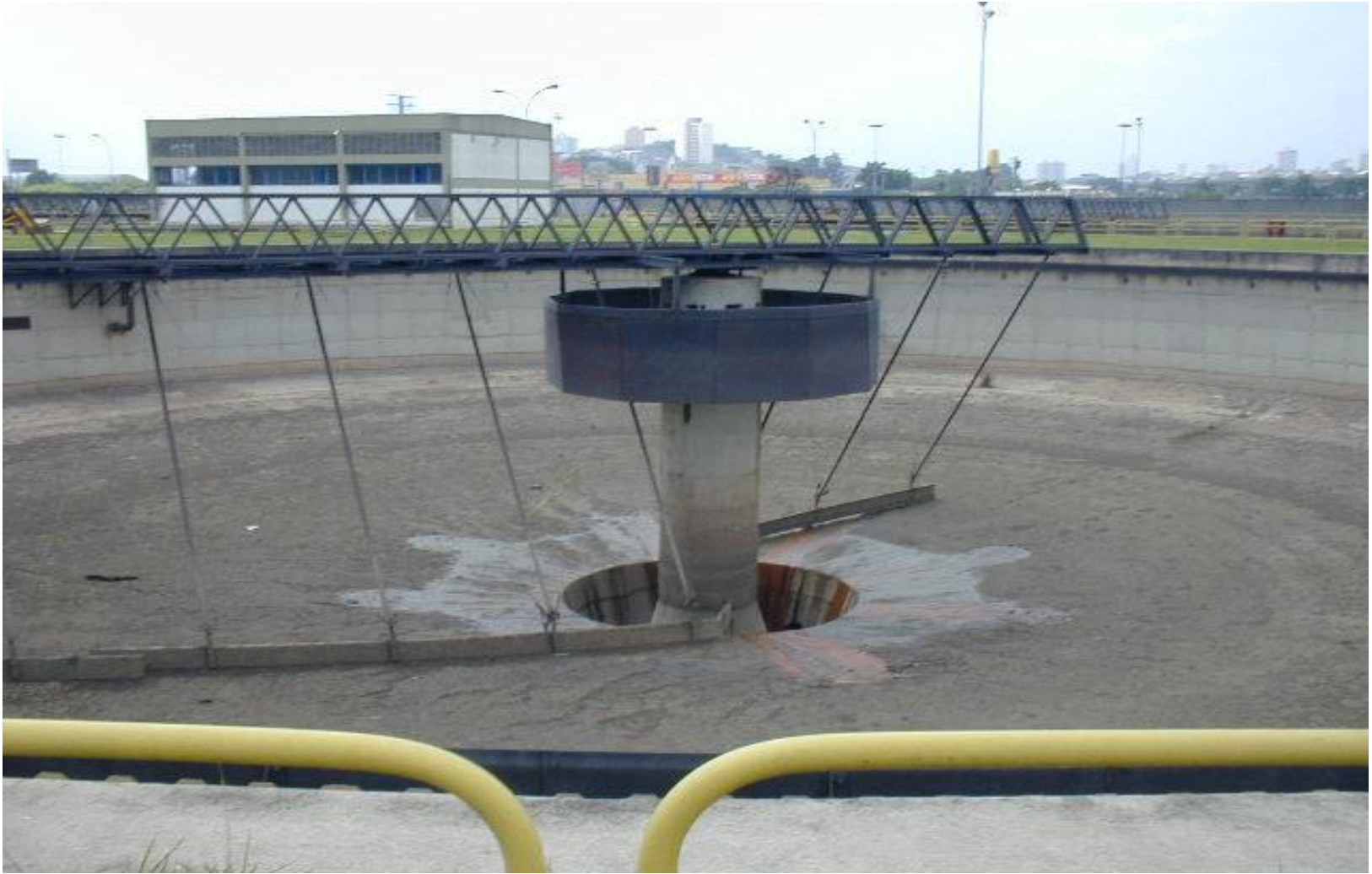
Implantação de decantador secundário de seção circular
